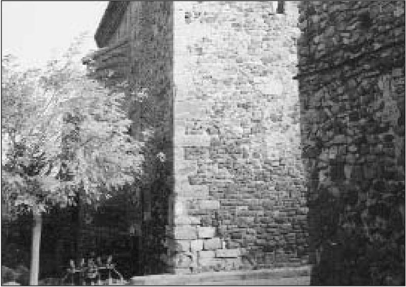
Fig. 9. Restos de materiales reaprovechados.
