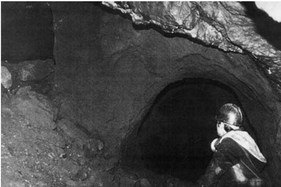
Fig. 2. Labores romanas en la mina “Santa Bárbara” de Oyarzun (Guipúzcoa). Obsérvese la excavación cuidada de la sección de la galería.
